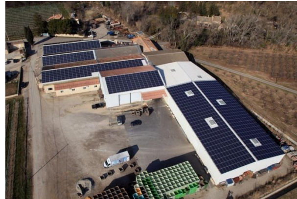
Photovoltaïque en toitures industrielles ou agricoles
